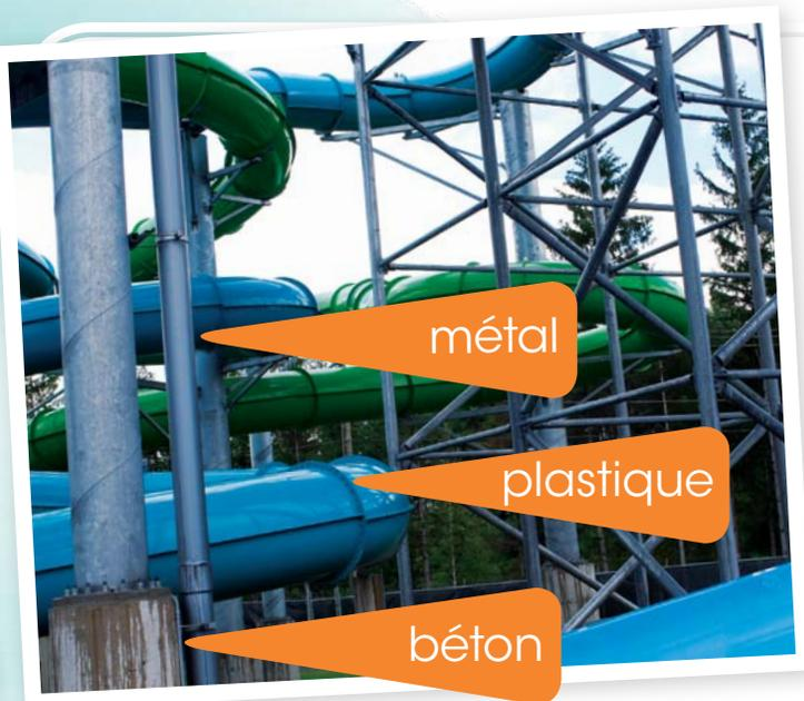
Les **matériaux** choisis pour la fabrication des structures dans un parc aquatique sont habituellement du **métal**, du **béton** et du **plastique** très robuste. Le métal et le béton sont des matériaux **solides**, **durables** et très **résistants**. Ils sont utilisés pour soutenir les glissades. Les glissades sont faites de plastique, un matériau **solide**, **imperméable** et **lisse**. Il peut aussi être **flexible**. Parfait pour le bien-être des personnes qui glissent!
