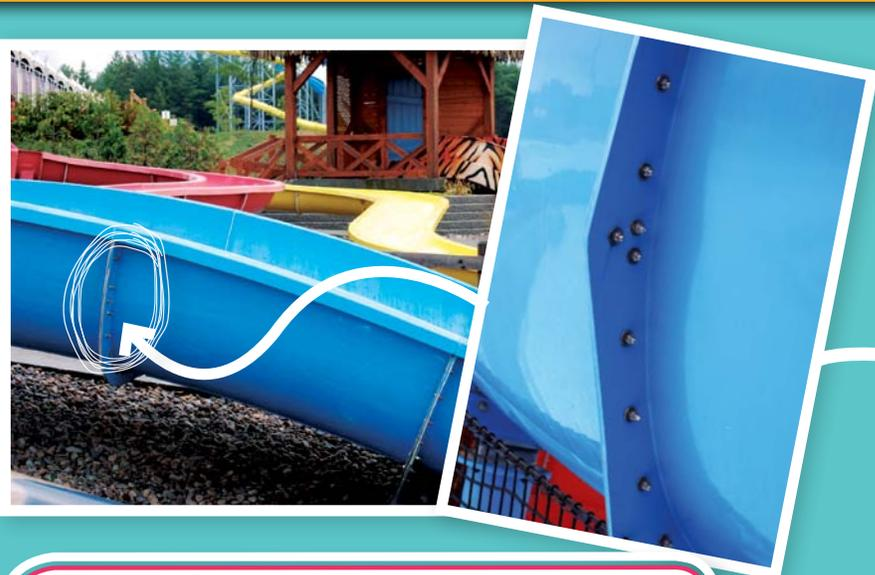
Le **pliage** est une autre façon de solidifier les structures. Chaque bout des segments de glissade est plié. Les deux parties pliées sont liées. Chaque segment est alors solidement attaché à un autre segment. Ainsi, une glissade peut être très longue.
