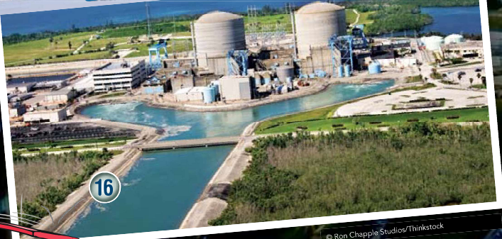
La centrale nucléaire produit de l'électricité grâce à la fission nucléaire de l'uranium.
